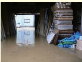
水害被害を受けた倉庫
