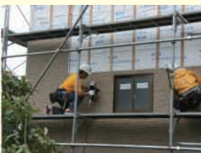
外壁の施工中
