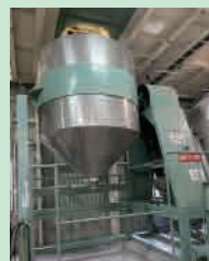
工場内の攪拌機
